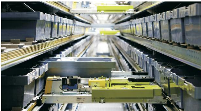
OSR-Shuttle-System im 30-gaisigen, automatischen Retourwarenlager von Otto-Versand, das Knapp für Hermes Logistik realisiert hat
