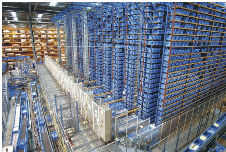
Automatisches Kleinteilelager bei der englischen Einzelhandelskette Argos. Das Distributionszentrum hat eine Fläche von 52 000 m 2
