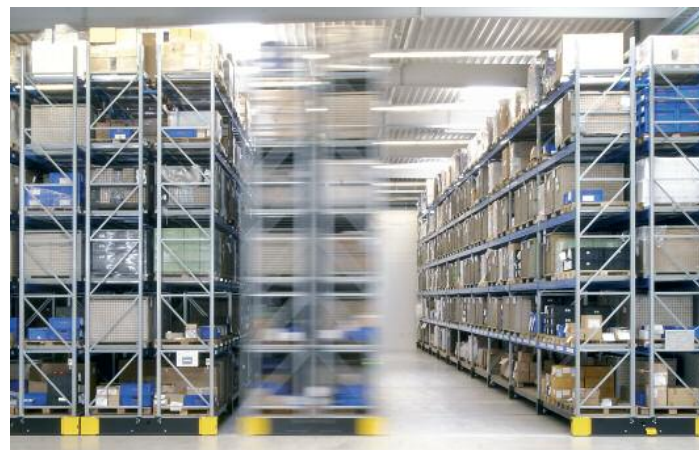
Die erforderliche Effizienz von verfahrbaren Regalanlagen lässt sich durch moderne Steuerungstechnik erreichen
